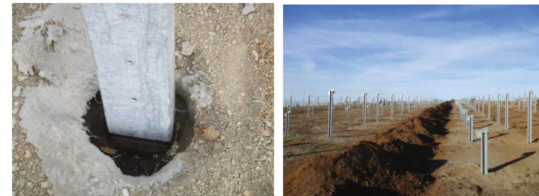
Exemple de fondations type pieux (photo RES)
