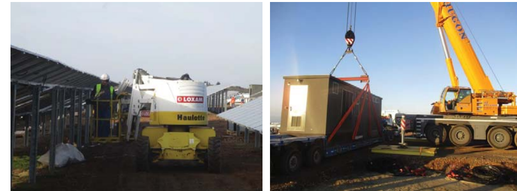
Exemple d'engin et de grue de levage (photo RES)
