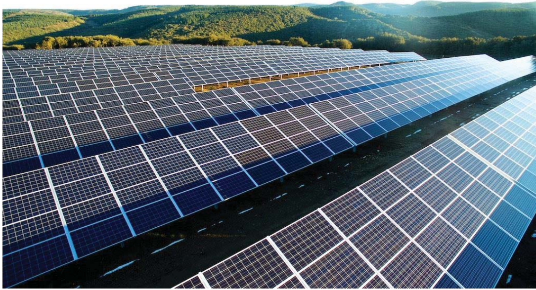
Exemple de structure fixe (photo RES)
