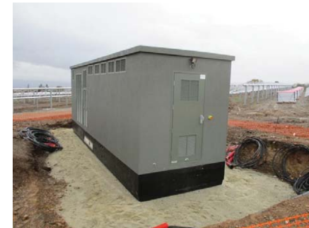
Exemple de lit de sable pour un poste électrique (photo RES)
