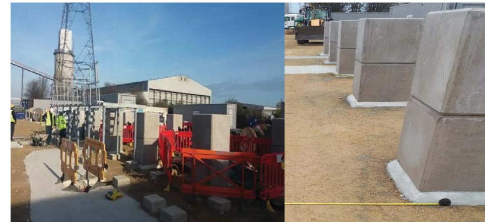
Photo plots béton de suélévation pour poste type « Skid » (photo RES)
