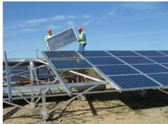
Exemple de mise en place des panneaux sur les structures (photo RES)
