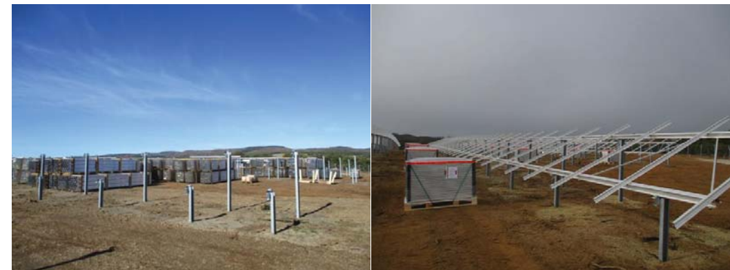
Assemblage des structures sur site (photo RES)
